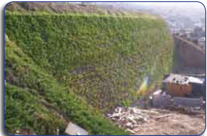
Ejemplo de muro de retención hecho de llantas enteras. Foto cortesía de la Comisión Estatal de Servicios Públicos de Tecate
