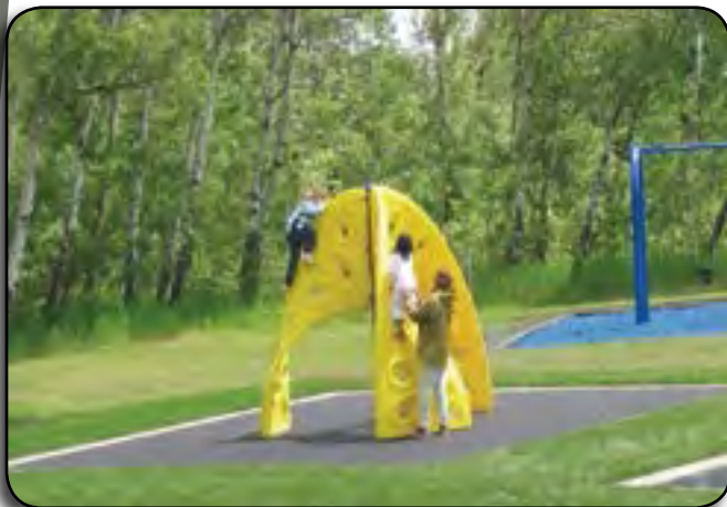
Figura 3-4. Instalación en la obra Foto cortesía de Calgary, Canada Parks and Recreation
